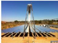
Diseño y ejecución de captador Fresnel de producción de calor para procesos industriales en cárnica Mafrica
